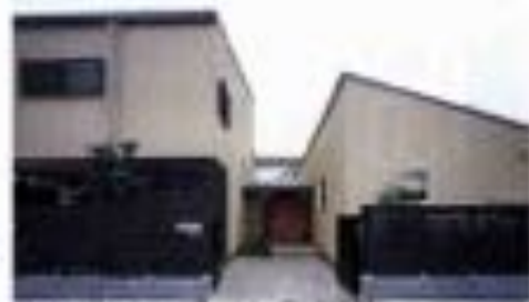
土/石造りの新築時の玄関。平屋時代の家は土/石造りの玄関。土/石造りの新築時の玄関。
