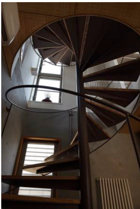
地下から螺旋階段を見上げる。
