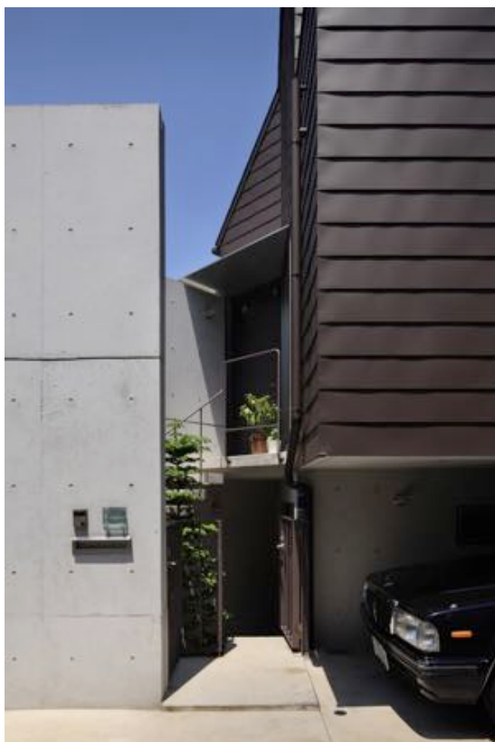
門扉から玄関を見上げる。 ポーチ底は溶融亜鉛メッキ。
