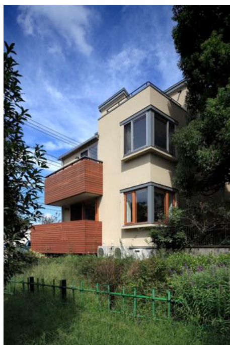
公園側からの外観。 出窓の上は屋上になっている。
